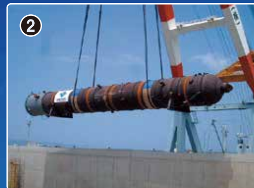
脱硫リアクター 寸法: 3,970ID×31,920L 板厚: 140.0mm 材質: SA387-22-2+TP347オーバーレイ
