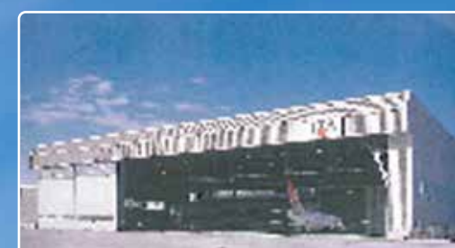
航空機格納庫 大扉
