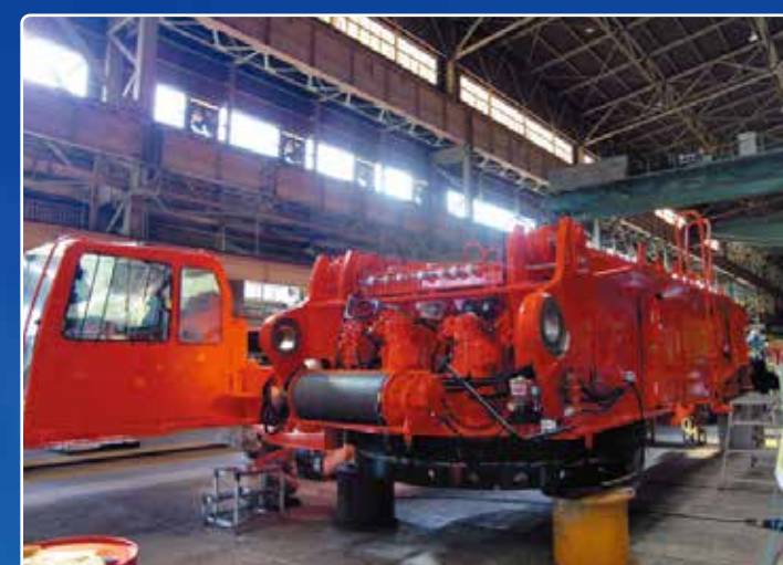
クローラークレーン組立状況
