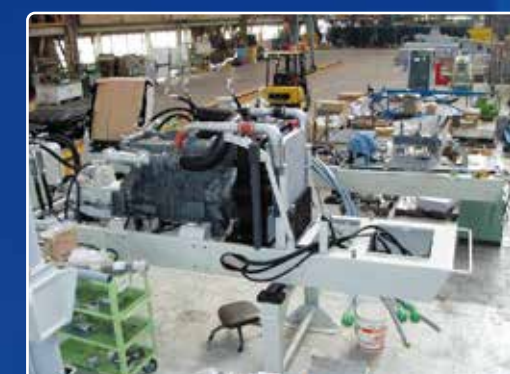
クローラークレーン組立状況
