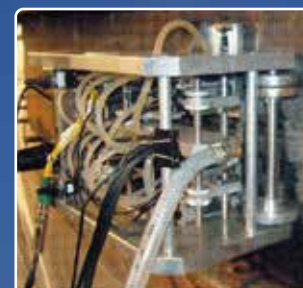
高温TOFD探傷試験 高温用探触子と高温用接触媒質による機器稼働中のTOFD検査
